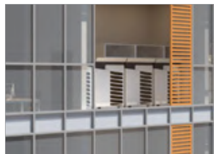
La unidad exterior queda oculta en el interior del edificio sin afectar a la estética
