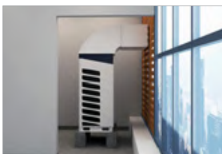
Instalación del conducto
