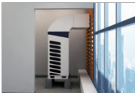
Instalación del conducto
