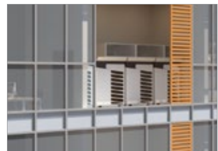
A unidade exterior fica escondida no interior do edifício sem afetar a imagem geral do edifício
