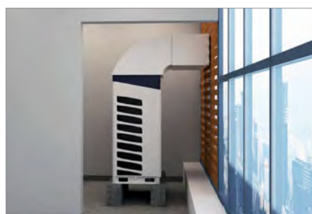
Installation des Kanals
