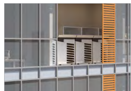
Die Außeneinheit ist im Gebäude versteckt, ohne das Gesamtbild des Gebäudes zu beeinträchtigen.
